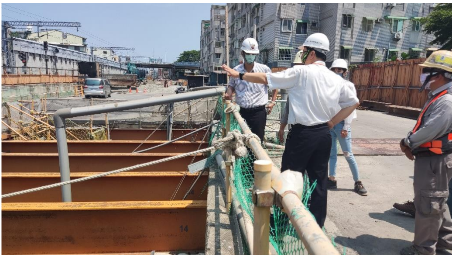
東區-鐵路地下化第214標
